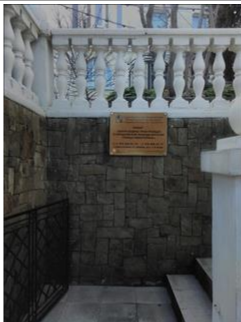
Информационная табличка на офисном здании проекта г.Севастополь, ул.Ленина , д.14 А, 1-й этаж
